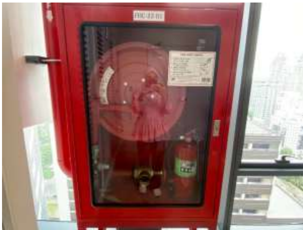
ตู้เก็บสายฉีดน้ำดับเพลิงและวิธีการใช้
