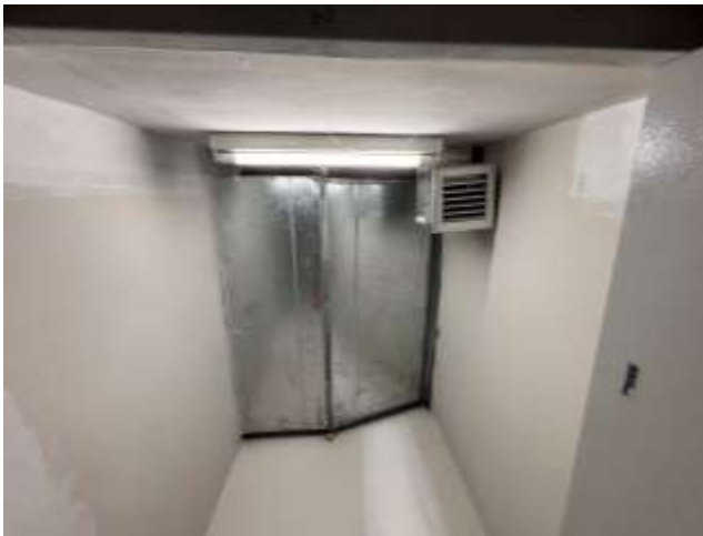
เครื่องดูดอากาศภายในห้องพักมูลฝอยรวม
