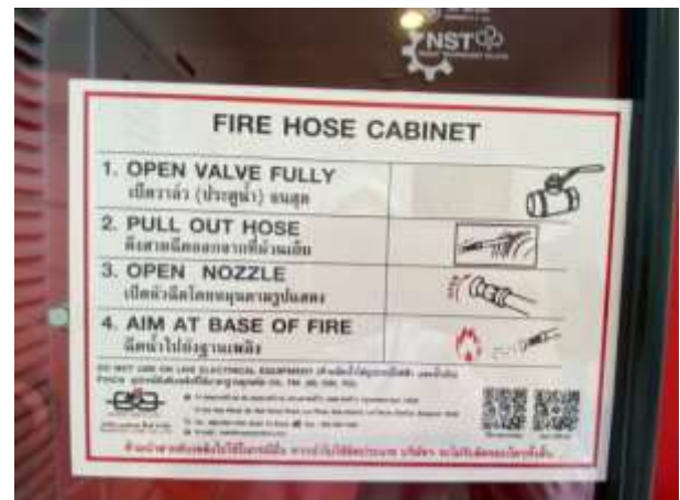
ตู้เก็บสายฉีดน้ำดับเพลิงและวิธีการใช้
